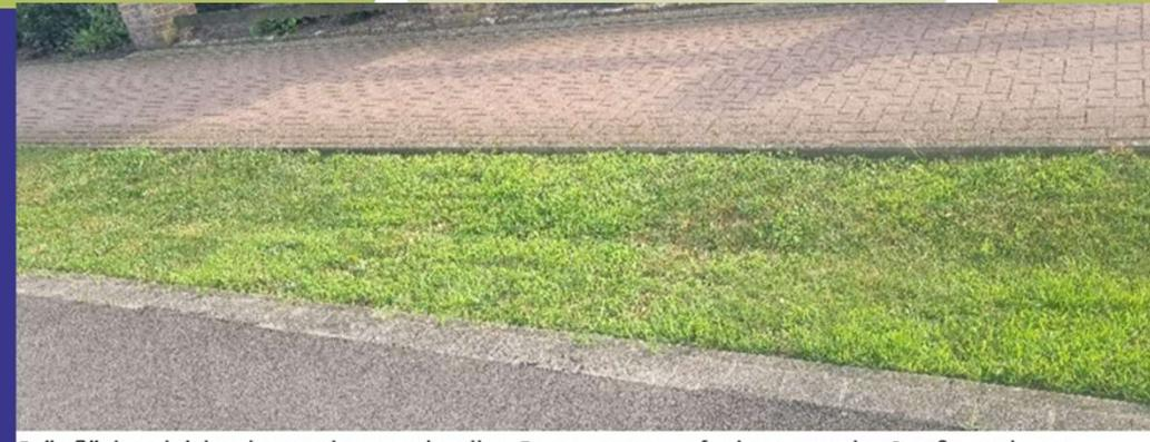
Grünflächen leicht abgesenkt zur schnellen Regenwasseraufnahme von der Straße und vom Gehweg mit Versickerung. Nach Regengüssen sind Wasserlachen nach kurzer Zeit nicht mehr vorhanden.
